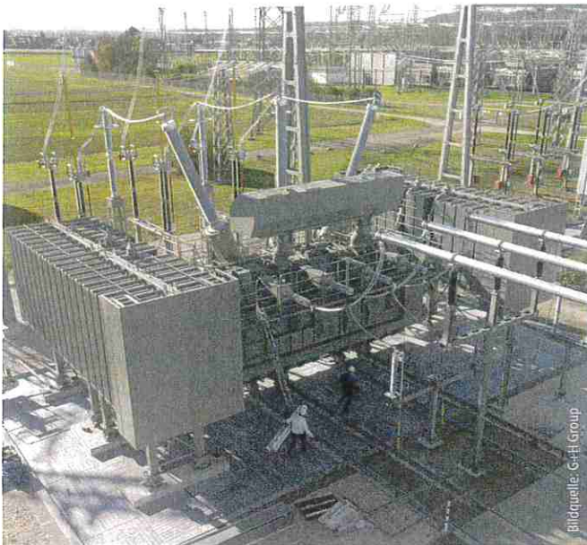
Ummantelung inklusive Öableitblech an einem Kühlaggregat
