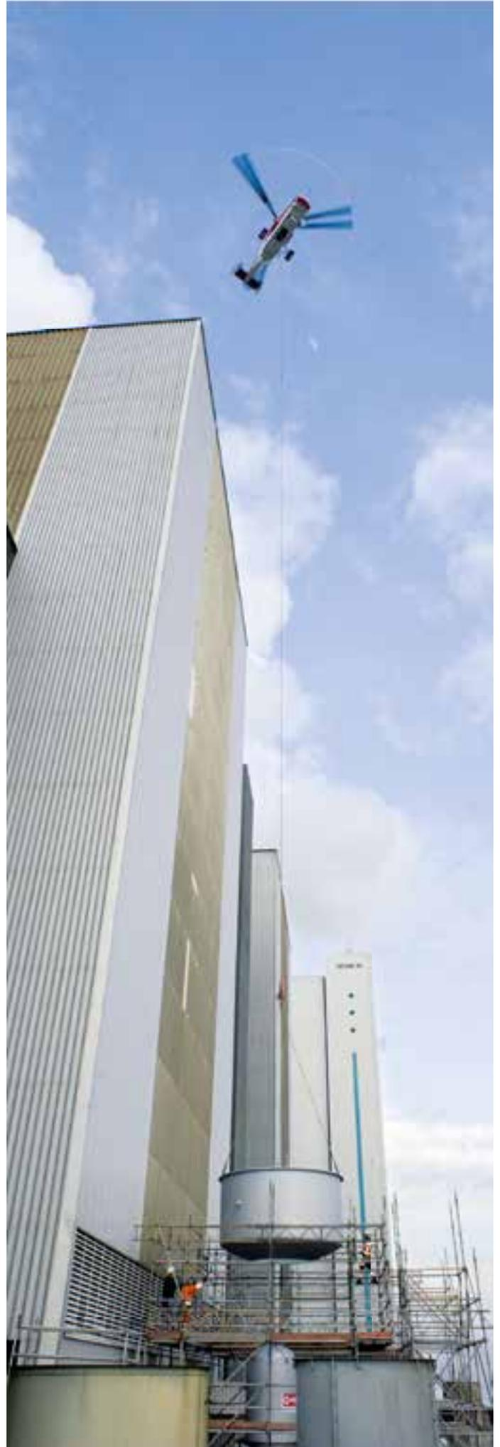
Die Ausblaseschalldämpfer werden von uns auf den jeweiligen Anwendungsfall maßgeschneidert und hinsichtlich der Abmessungen und Gewichte optimiert. Die festigkeitstechnische Auslegung der Druckteile der Schalldämpfer ist nach den gängigen in- und ausländischen Regelwerken möglich. Wir verfügen über qualifizierte Fertigungsmöglichkeiten für ferritische, austenitische sowie martensitische Werkstoffe (z. B. P 91).
